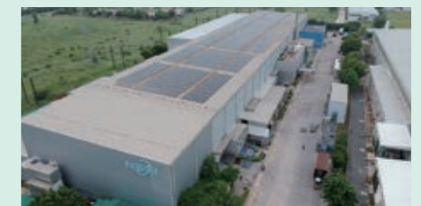
Neemrana Steel Service Center India Pvt.Ltdの屋根置き太陽光発電システム
